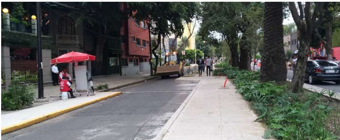
Imagen 7. Pacificación del tránsito a través del estrechamiento de carriles y construcción de una chicana
